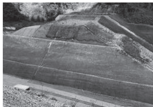
写真-3 滝の沢ため池 堤体掘削断面
