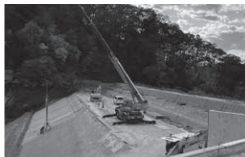
写真-2 伏熊ため池 ベントナイトシート施工中
