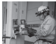
コンクリートコア採取状況
