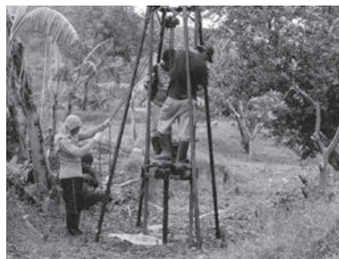
写真-4 調査中の一コマ 3. フィリピンでのボーリング調査状況 (ボーリングマシンを上下させる掘り方)
