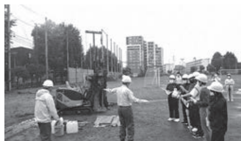
令和4年 建築土木科 1年ボーリング実習
