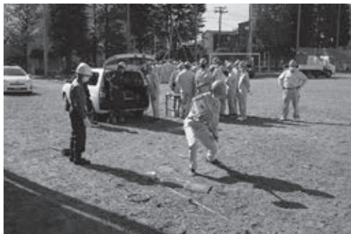
令和4年 土木科1年 表面波探査実習
