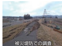
被災堤防での調査
