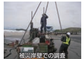
被災岸壁での調査
