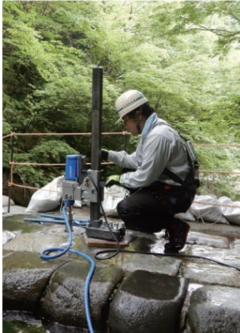
写真-1 コアドリルによる掘削状況
