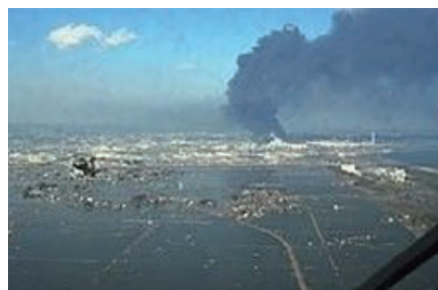
図-2 東北地方太平洋沖地震の巨大津波による仙台市宮城野区沿岸被災写真(引用文献(2))
