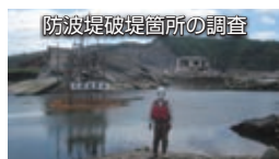
防波堤破堤箇所の調査
