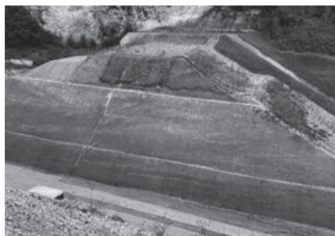
写真-3 滝の沢ため池 堤体掘削断面
