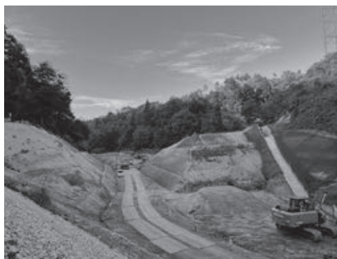
写真1 滝の沢ため池
