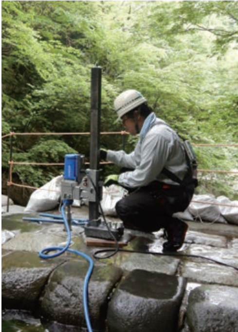
写真-1 コアドリルによる掘削状況
