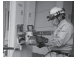
コンクリートコア採取状況
