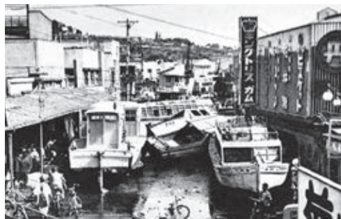
図-4 チリ地震津波による塩釜市内に乗り上げた船などの被災写真（引用文献(4)）
