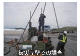
被災岸壁での調査
