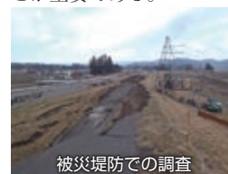
被災堤防での調査
