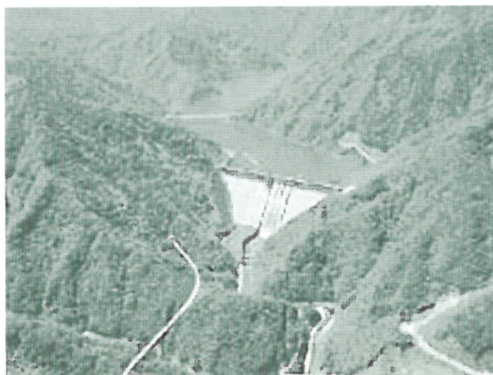
長井ダム完成予想写真「ダム下流より」
