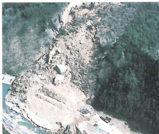
山館地すべり全景【岩手県提供】
