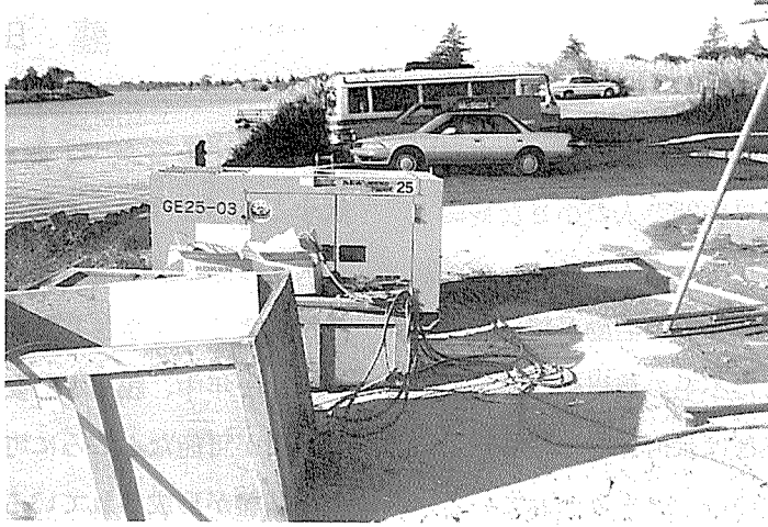
全自動貫入試験の動力源（発電機）
